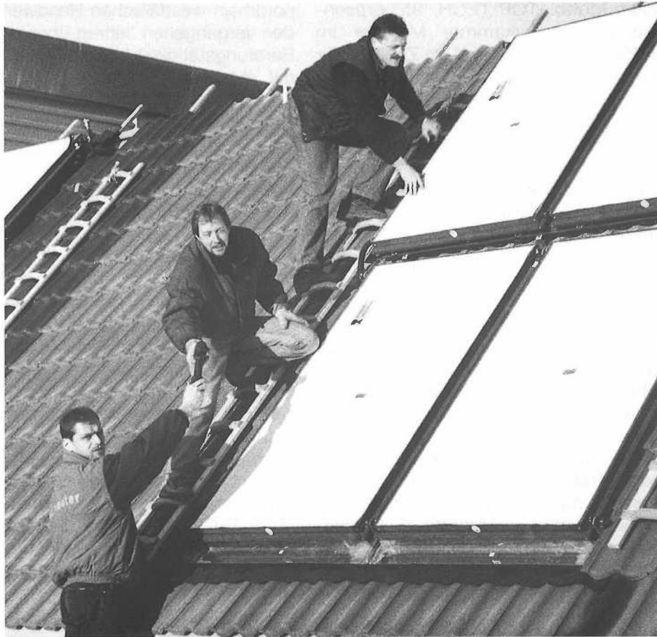
**Training für die Praxis.** Auf dem Dach des Handwerkskammer Bildungszentrums ist eine Solaranlage installiert, an der Lehrgangsteilnehmer die fachgerechte Planung, Montage und Wartung trainieren.
